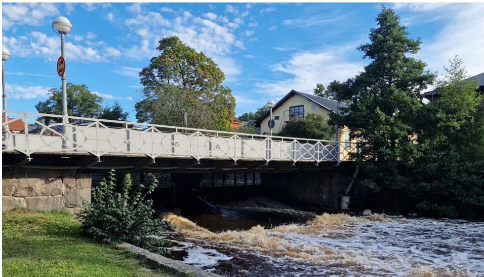
Figur 1. Nedströmsvy av Dammbron i Köpingsån belägen i centrala Köping.
