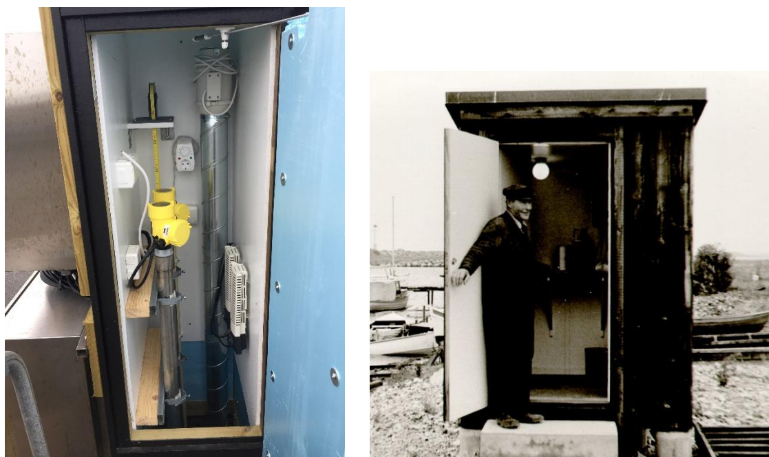
Figur 2. Till vänster: inuti mätstationen i Skanör. I bakgrunden syns måttbandet och i förgrunden de båda sensorer med vilka vattenståndet mäts. Till höger: äldre bild från mätstationen i Klagshamn. Foton: SMHI.
