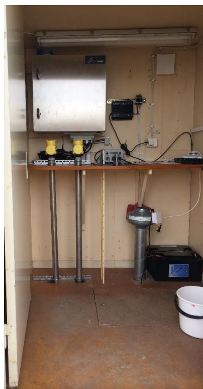
Figur 2. SMHIs mätstation i hamnen i Klagshamn. I bilden till höger syns mätutrustningen inne i stationen, två radarsensorer i rör och ett mekaniskt måttband till höger om dessa. Foton: SMHI.
