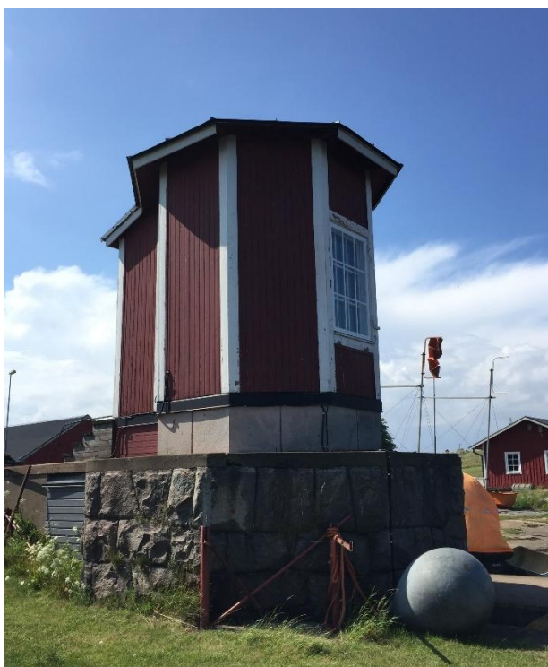
Figur 2. SMHIs mätstation Kungsholmsfort. Foto: SMHI.
