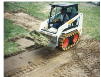
Bild 2. Sanering av kontaminerad mark.
