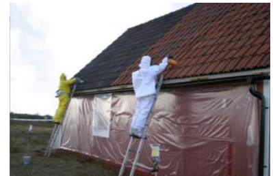
Bild 1. Sanering av byggnad.
