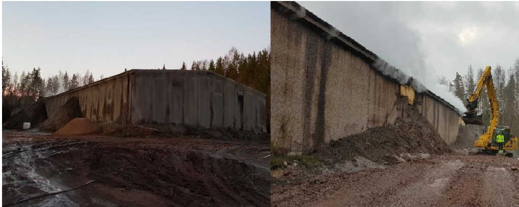
Figur 6. Byggnaden inkapslad med sprutbetong till vänster och vägen som fick byggas till höger. Foto: Räddningstjänsten Östra Skaraborg.
