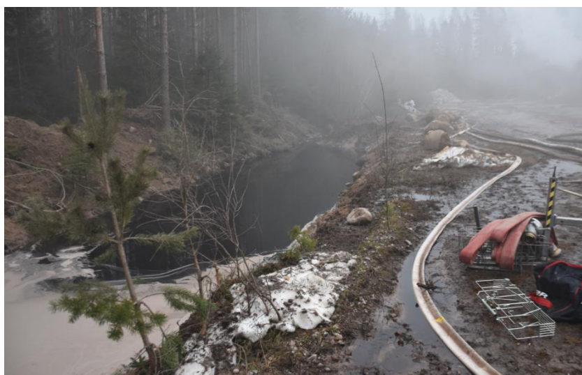
Figur 8. Ett av diken som grävts ut för att samla upp spillvatten. Foto: Räddningstjänsten Östra Skaraborg.
