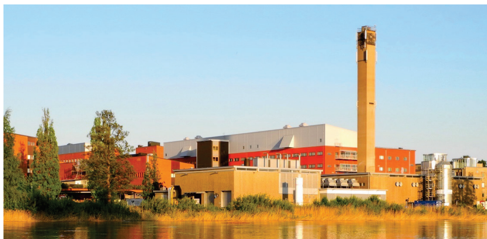
Figur 5: Centralsjukhuset i Karlstad. Foto: Jan-Olov Moberg.
