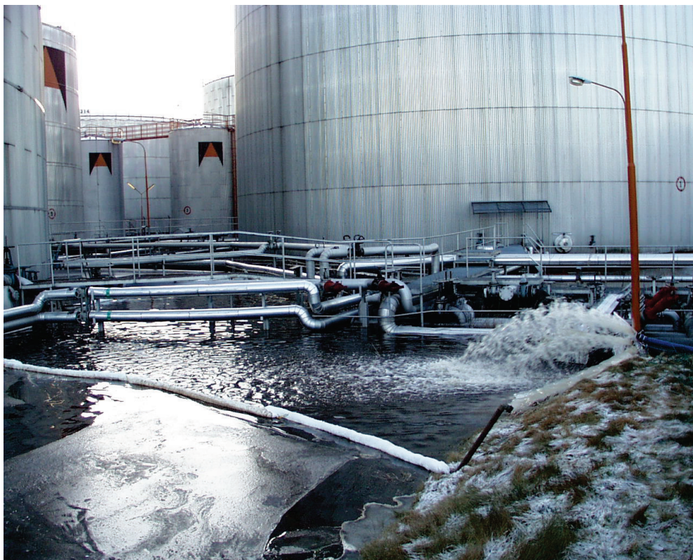
Figur 15: Foto från Karlstads oljehamn 2000-12-27, då vattennivån i Vänern var 25 till 30 centimeter under scenario V1. Foto erhållet genom Göran Engström (tidigare anställd vid Karlstads kommun).
