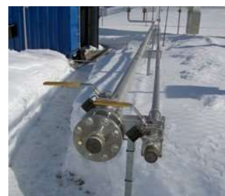
Figur 40. Exempel på rörledning med öppen ände. Foto: MSB.
