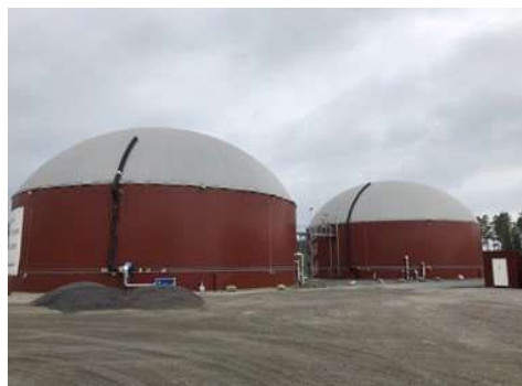
Figur 39. Rötkammare med membranöverdel. Foto: David Gårsjö.
