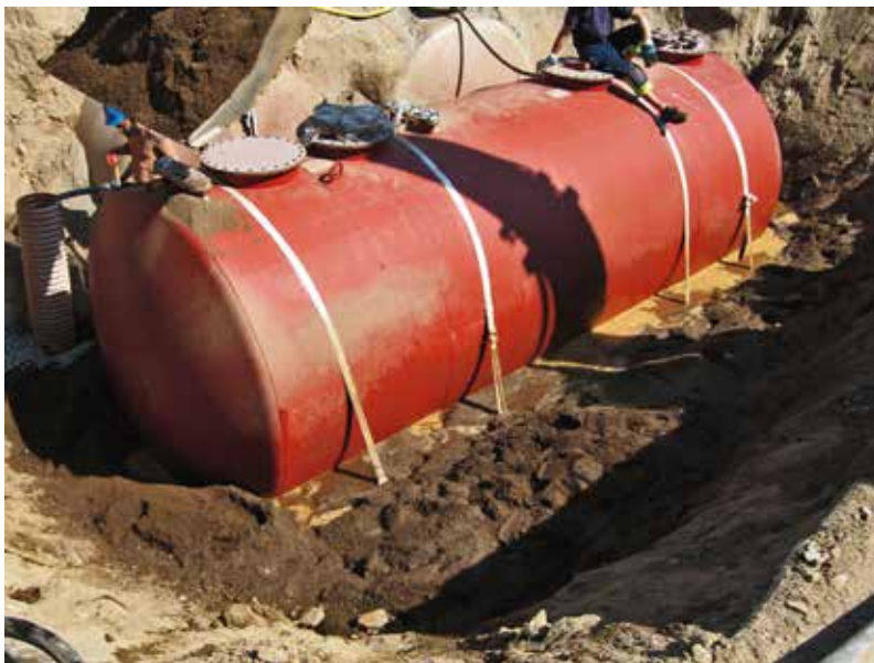
Cistern förbereds för installationskontroll
