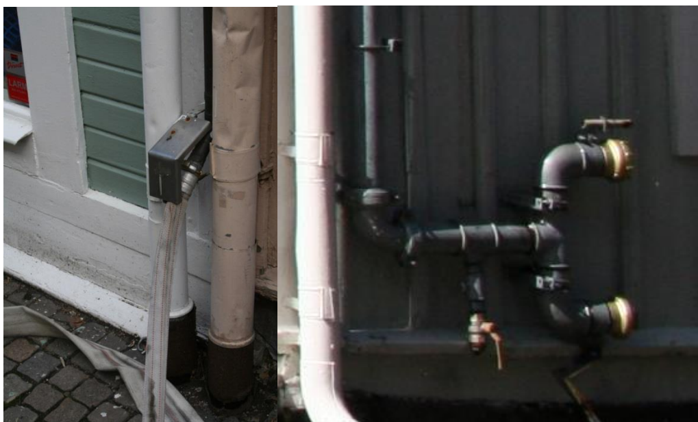
Bild 1 Inkoppling av vindssprinkler t.v. och kopplingar för fasadsprinkler t.h.
