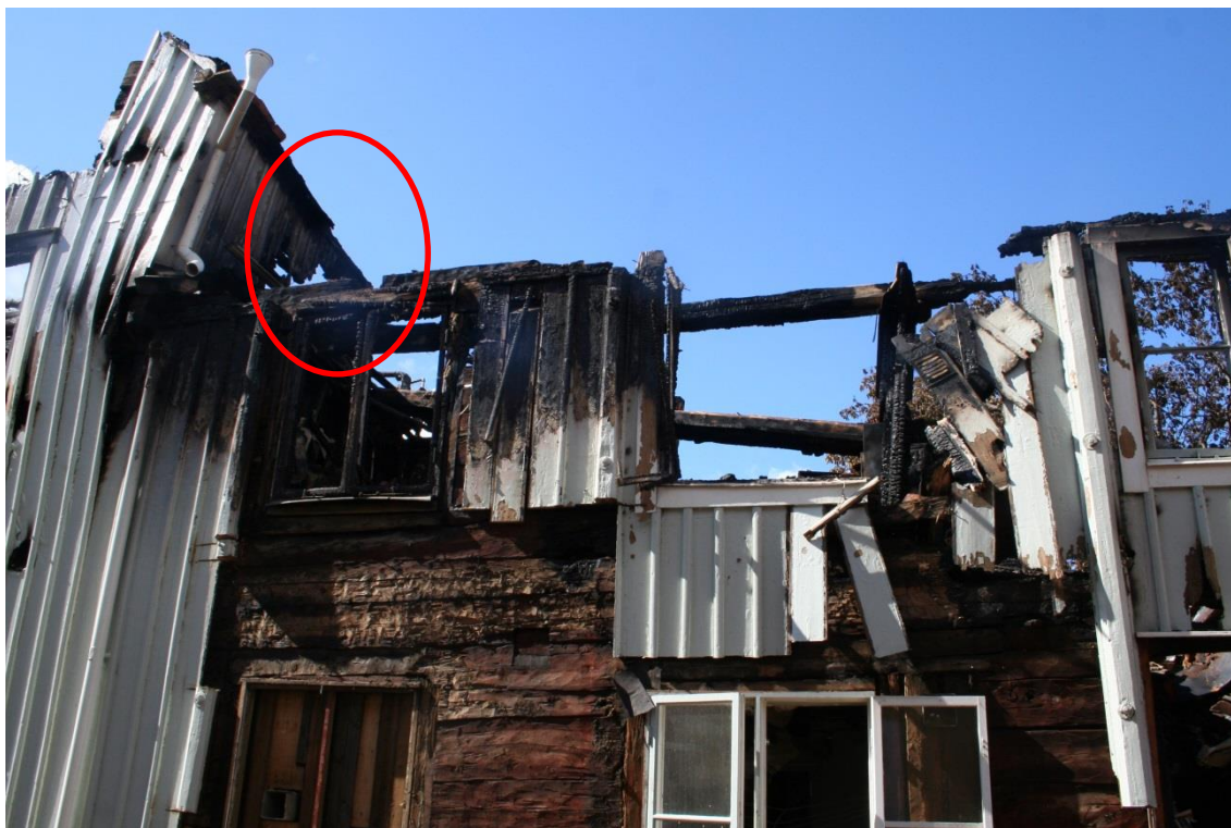
Bild 7 Den högre belägna vinden som branden snabbt spreds via.
