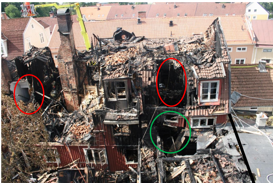
Bild 10 Det nordöstra hörnet mot Norra storgatan. Det svarta strecket visar fastighetsgräns vid vilken branden kunde stoppas. Den gröna ringen visar var spridning från gårdshus till andra byggnaden skett. De röda
