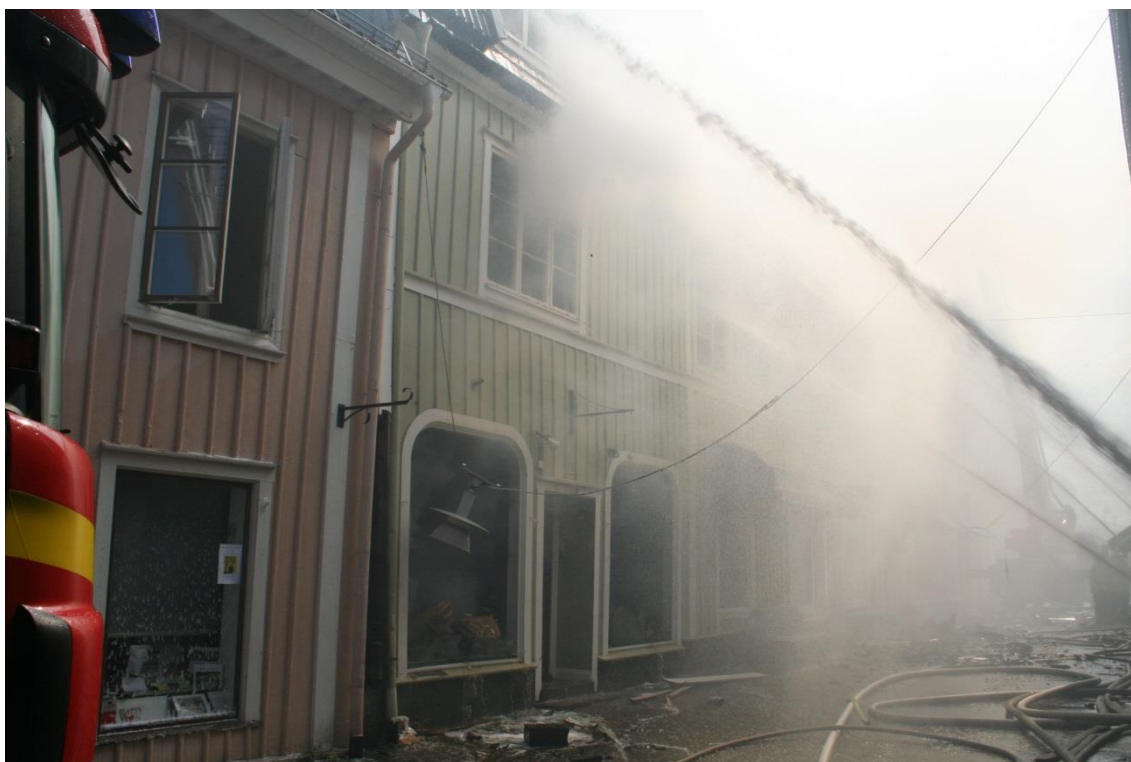
Bild 3 Kraftig vattenbegjutning av fasaden mot Norra storgatan
