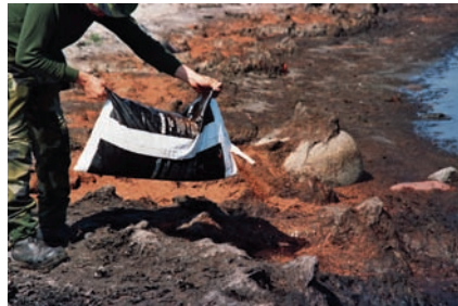
Manuell spridning av organisk absorbent (bark).
