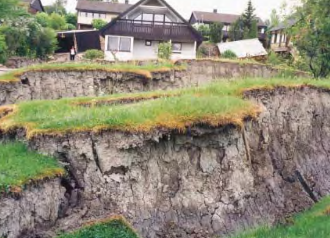
Figur 4.12. Skredet i Vagnhärad, 1997.
